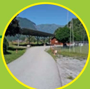
Page 8 & 9 Les travaux
