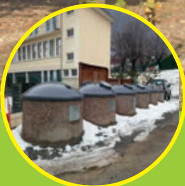
Page 8 & 9 Les travaux
