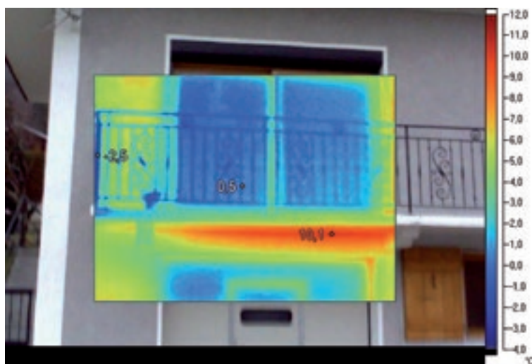
Thermographie pour repérer les zones à isoler
