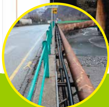
Page 8 et 9 Les travaux
