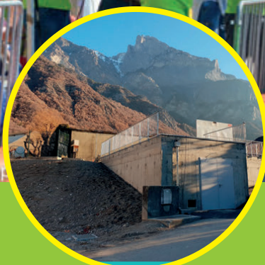
Page 8 Les travaux
