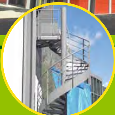
Page 8 Les travaux
